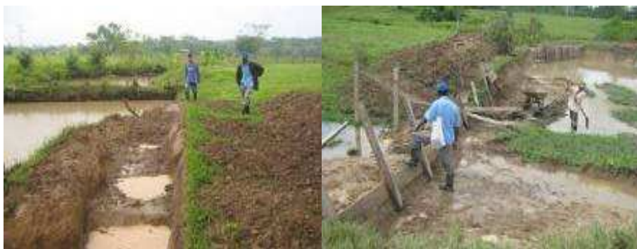
Adecuación y mejoramiento de estanques en la vereda Bajo Cuembí Corregimiento Perla Amazónica Municipio de Puerto Asís
