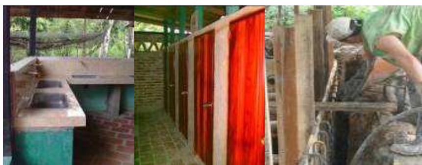
Obras complementarias de las unidades sanitarias en ASOMI
