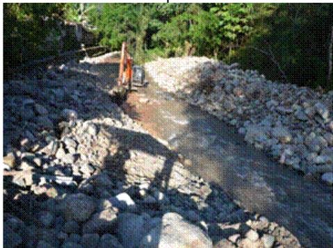
**Foto 4.** Conformación de enrocado sobre orilla
