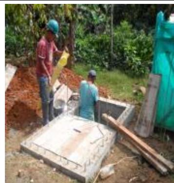
**Foto 3.** Construcción de pozos sépticos
