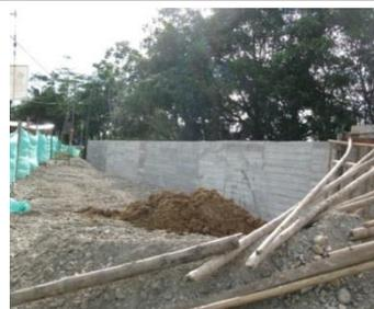
**Foto 2.** Excavaciones y mejoramiento del suelo en material seleccionado
