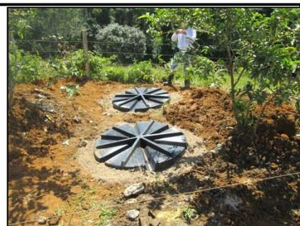
**Foto 3:** Tanques sépticos; Resguardo Aguanegra, Municipio de Milán.
