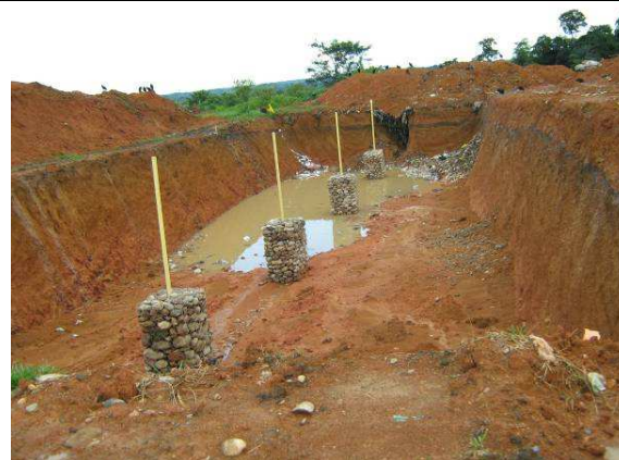
Figura 2. Celda de disposición residuos sólidos El Doncello
