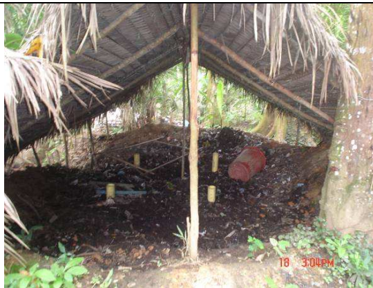
Figura 3. Celda de disposición residuos sólidos Puerto Nariño
