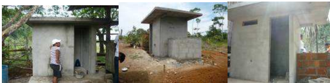
Construcción Unidades Sanitarias Puerto Umbría
