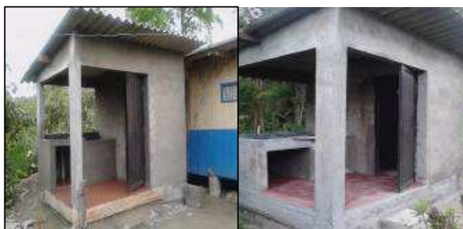
Trabajos adelantados en las veredas; La Menta, San Agustín, San Silvestre Municipio de San Francisco.
