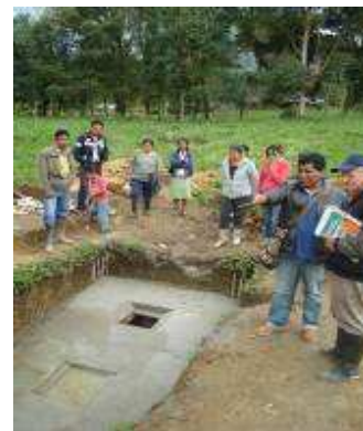
Después de la construcción pozo séptico
