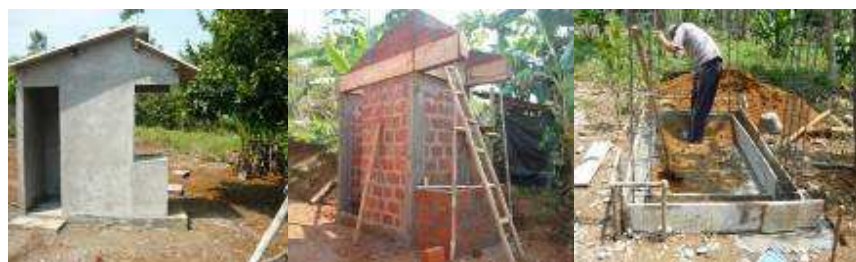
Avances en la construcción de unidades sanitarias en comunidades Indígenas y Afro del Municipio de Puerto Caicedo.
