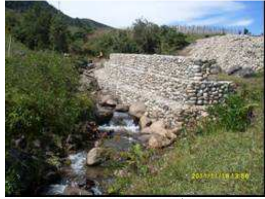
Gaviones de Protección
