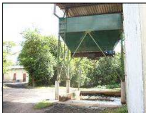
Tolva de almacenamiento contenido ruminal
