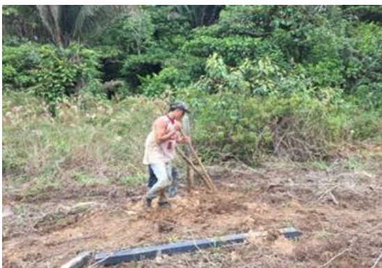
Realización de Aislamiento predio El Mirador
