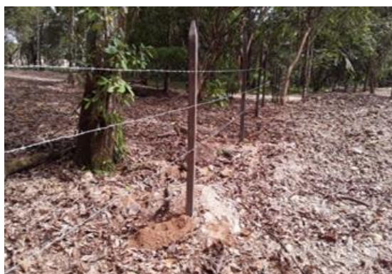
Realización de Aislamiento predio San Fernando
