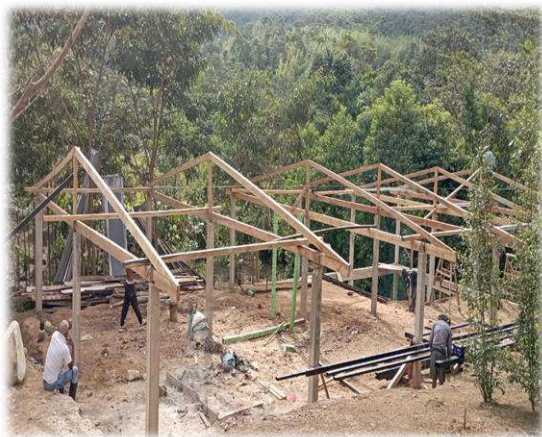
Infraestructura de la cubierta para el techo de la casa de remedio
