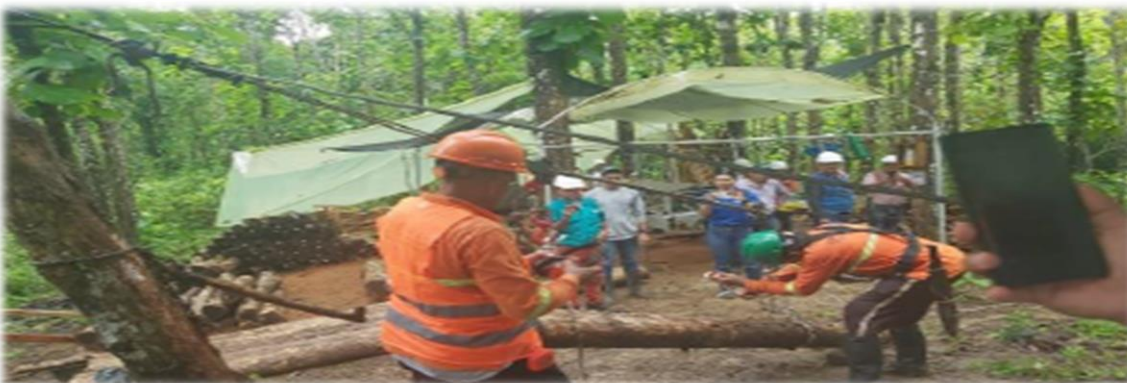
Fotografía. Observación del sistema de cable aéreo
