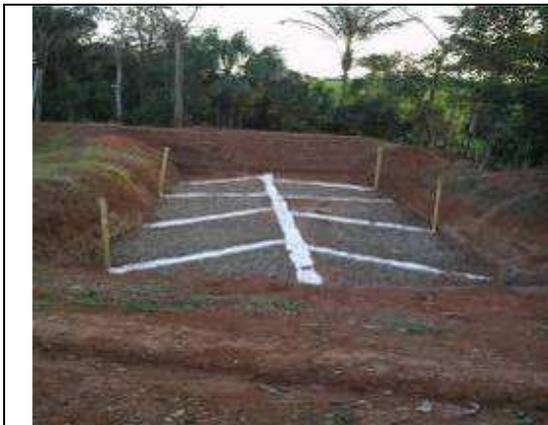
**Foto 4.** Celda de disposición residuos sólidos Curillo
