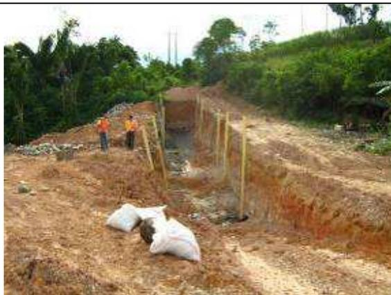
**Foto 5.** Celda en construcción para disposición residuos sólidos San Vicente
