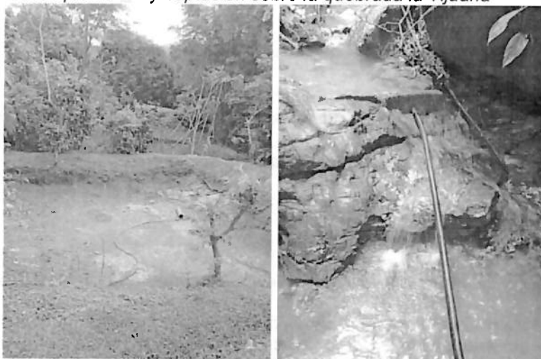
6-7 estanque vacío y captación sobre la quebrada la Tijuana
