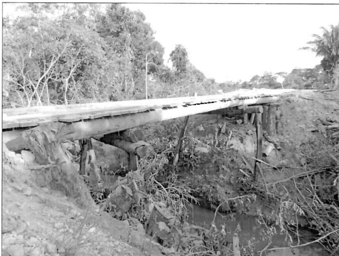
Imagen 6. Puente provisional que comunica vía terrestre el municipio de La Montañita – San Antonio de Getuchá – municipio de Milán construido por la comunidad.
