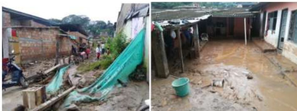
Fotografía 12. Viviendas afectadas por la inundación en el barrio El Progreso
