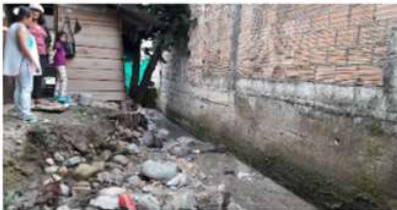
Fotografía 13. Viviendas afectadas por la inundación producto de la quebrada Taruquita
