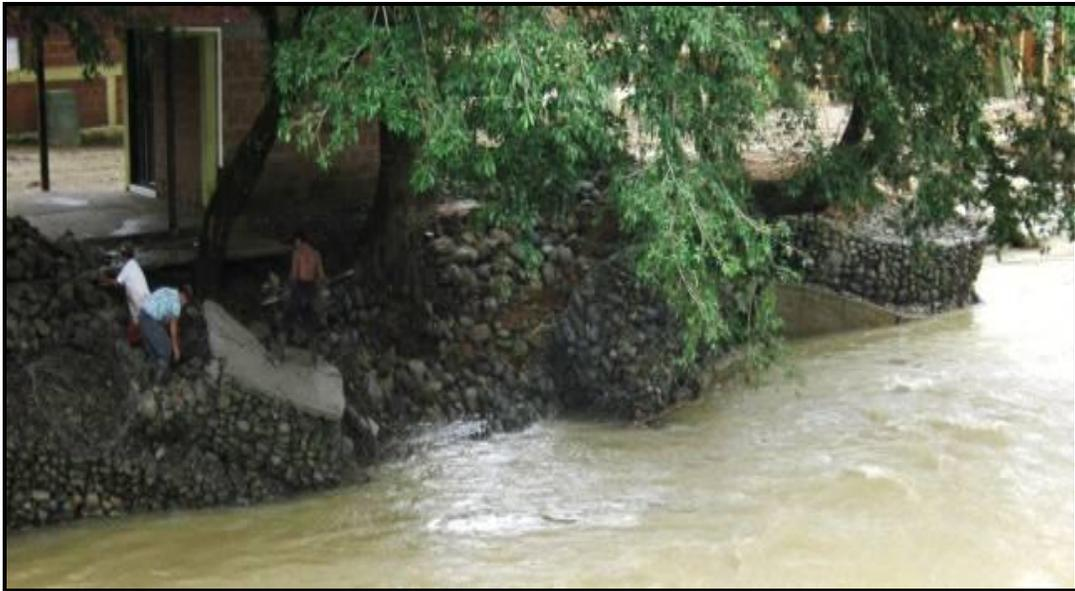
Afectación del muro de contención por efecto de la corriente (Río Rumiayaco)
