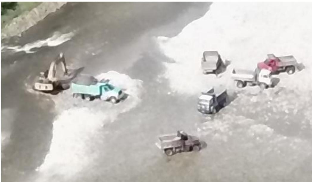
Figura 10. Figura donde se puede observar el método de explotación actual (franjas paralelas al cauce). Las volquetas se estacionan de manera desordenada y transitan por el cauce del río.
