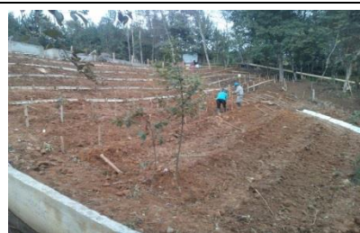
Foto 1: Vereda Bellavista, Municipio de Sibundoy (Construcción de anillos para
