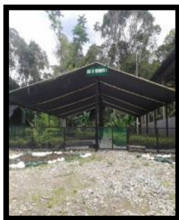
Vivero forestal CEA (Ampliación infraestructura)
