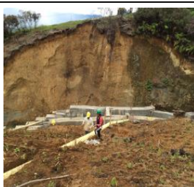
Foto 2. Quebrada La Cofradía; San Francisco (empadización y
