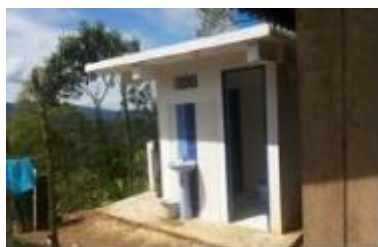
Unidades sanitarias y sistema de tratamiento de aguas residuales Mocoa-Putumayo
