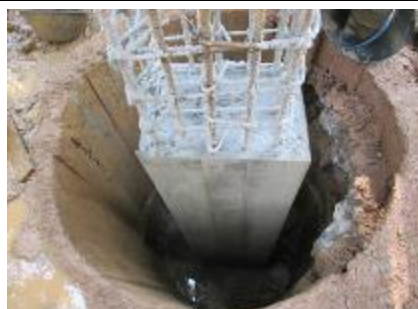
Obras De Prevención Del Riesgo, Calle 6 Entre Carreras 9 Y 13 Ladera Posterior Barrio Kennedy, Municipio De Mocoa
