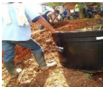
Verificación de instalación tanque desnatador beneficiario Julio Martínez
