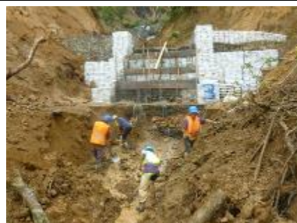
Obras De Prevención Del Riesgo, Alto San Pedro Quebrada Las Lajas, Municipio De Colon Departamento Del Putumayo
