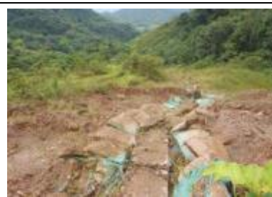
Remoción en masa por flujo de lodos, roca y detritos
