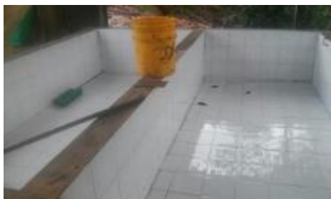
Construcción interna de tanque tina del beneficiario DUVER ANDRES GONZALES c.c. 17688215, (Enchape) de tanque tina interna para lavado de café.
