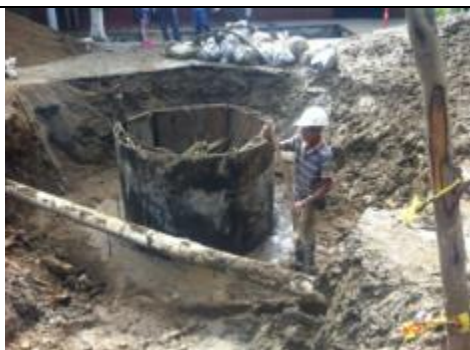
Construcción de pozo
