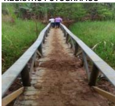
Foto 2. Construcción de puente elaborado con plástico reciclable.
