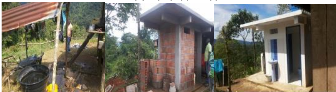
Construcción de unidades sanitarias y sistema de tratamiento de aguas residuales.
