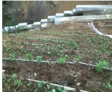
Foto 2. Quebrada La Cofradia, Municipio de San Francisco (Trinchos y canales en suelo cemento).
