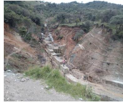
Foto 3. Quebrada El Diamante; Municipio de San Francisco (construcción de diques y gaviones).
