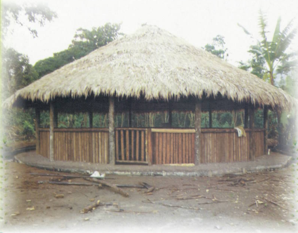
Casa del yagé ubicada en la comunidad Inga de Yunguillo, municipio de Mocoa.
