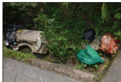
**FIGURA 5.** Problemas de las cunetas y desagües, por la falta de mantenimiento: Daño estructural Km 1.5, Daño estructural Km 2.5, Colmatación de box coulvert a la altura del colegio San Juan Bosco, en el área de influencia de la quebrada de Yahuaracaca, Municipio de Leticia, Departamento de Amazonas.
