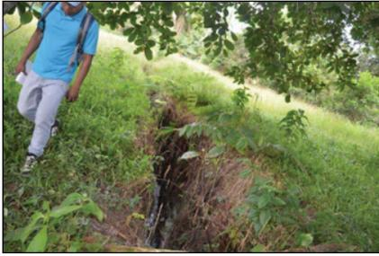
**FIGURA 8.** Problemas con las cunetas para conducir las aguas servidas y las aguas lluvias hasta los desagües de la vía principal (carretera Leticia-Tarapacá): cuneta de desagüe en el Castañal II, desagüe en la vivienda del Castañal II, erosión en forma de cárcava en el Castañal de los Lagos, Municipio de Leticia, Departamento de Amazonas.
